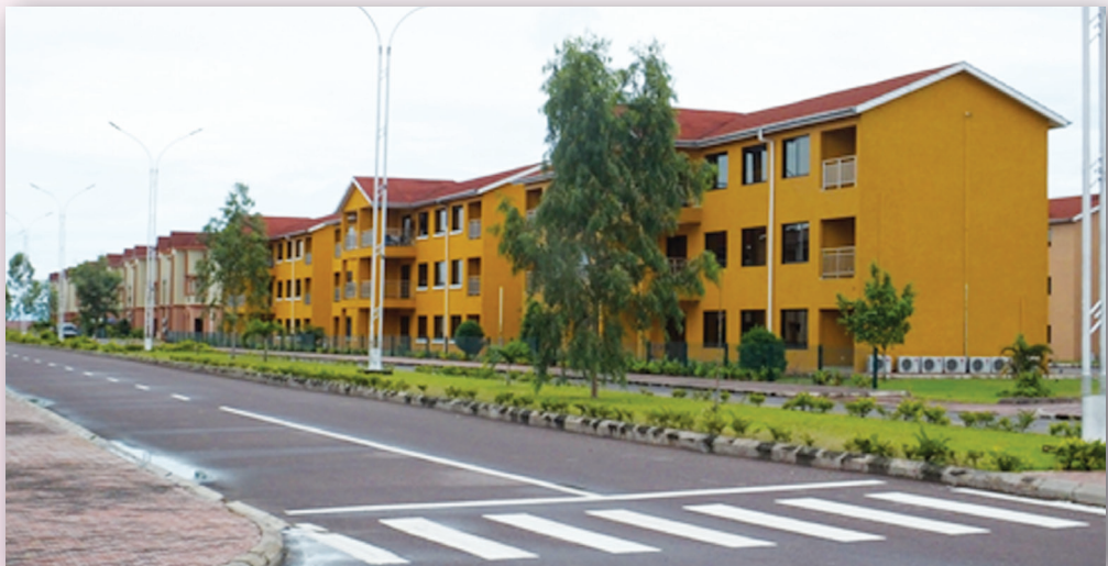
Cité OASIS à Bandalungwa dans la Ville-Province de Kinshasa
