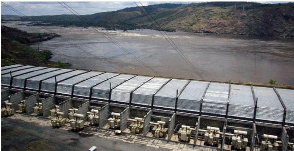
Site du barrage d'Inga dans la Province du Kongo-Central
