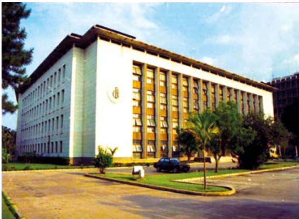
Siège de la Banque Centrale du Congo à Kinshasa
